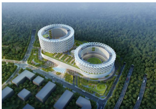
大鹏新区人民医院项目
